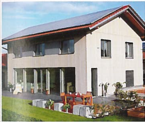
84558 KIRCHWEIDACH | Holzbau Gruber
